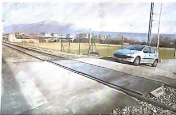
Uno dei passaggi a livello lungo la tratta ferroviaria
